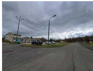
Öffentlicher Parkplatz am Eingang Süd
